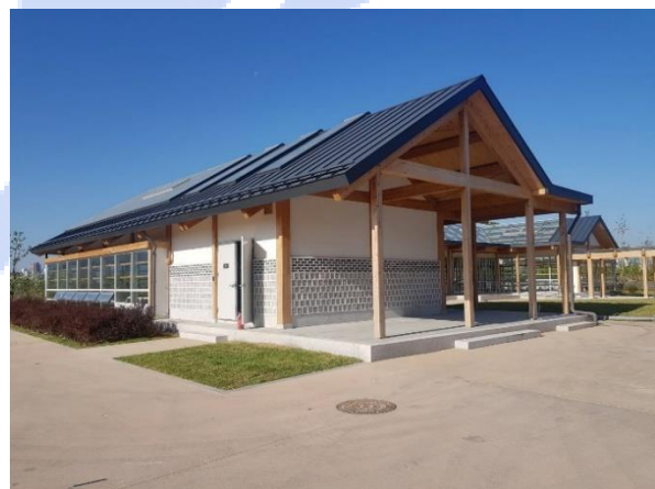
宮崎県産スギを使用した公共施設
