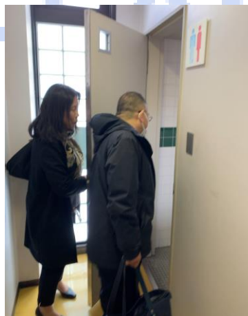
学生寮内のトイレを確認
