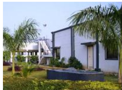
エントランス周辺
